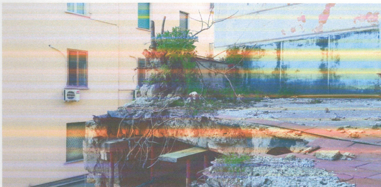
Condizione delle murature – infiltrazioni radicali
