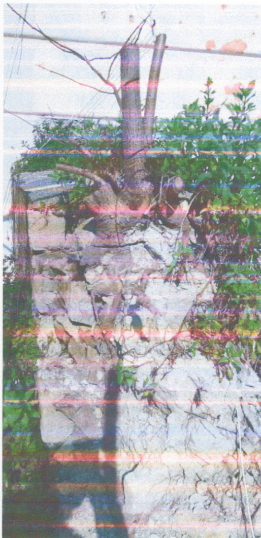
Condizione delle murature – infiltrazioni radicali
